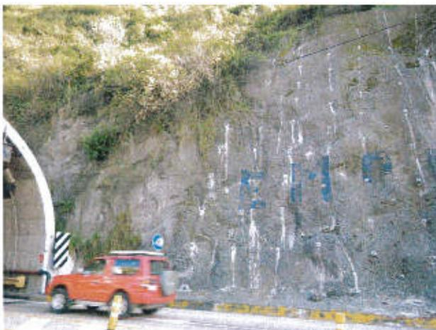
Talud gunitado y anclado a la salida del túnel.
