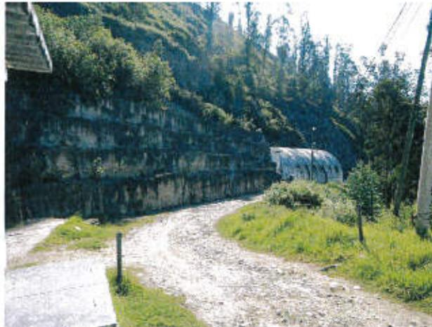
Falso túnel de protección frente a la caída de bloques.
